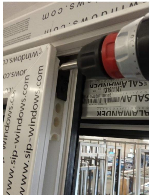
Obr. .... Demontáž krycí lišty křídla. Obr. ... Odšroubování šroubu připevňujícího věšák
