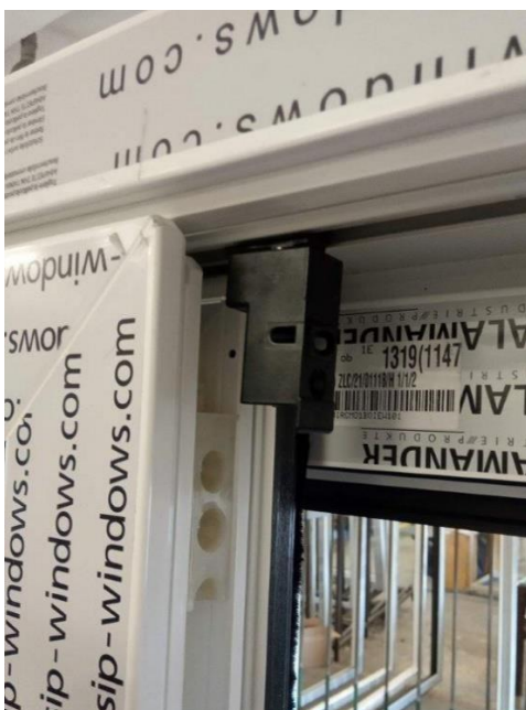
Obr. .... Demontáž věšáku. horní kolejnici.
