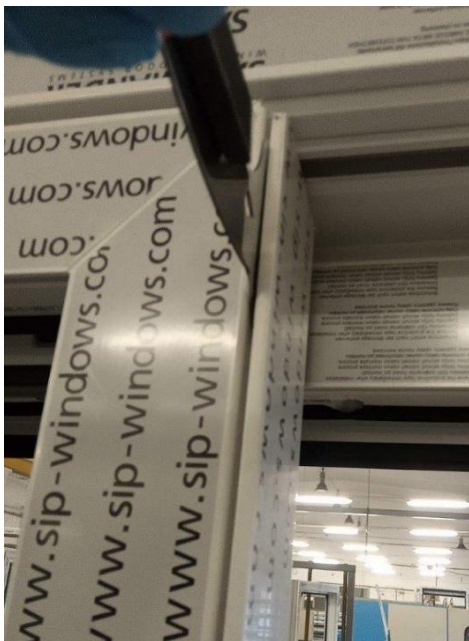
Obr. .... Demontáž krycí lišty křídla. Obr. ... Odšroubování šroubu připevňujícího věšák
