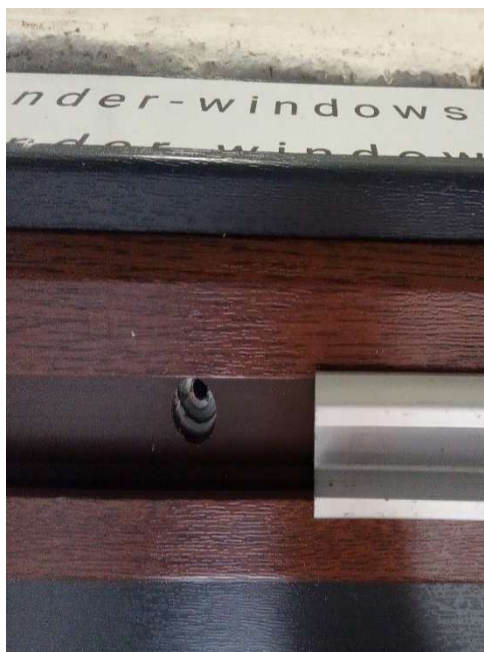
Fig... Démontage du support Fig... Trou pour la cheville sous le rail supérieur.
