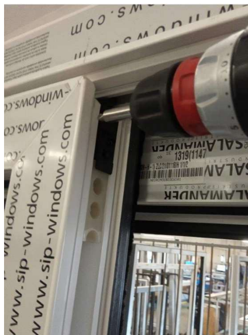
Fig... Démontage du cache du vantail. Fig... Dévissage de la vis fixant le support.
