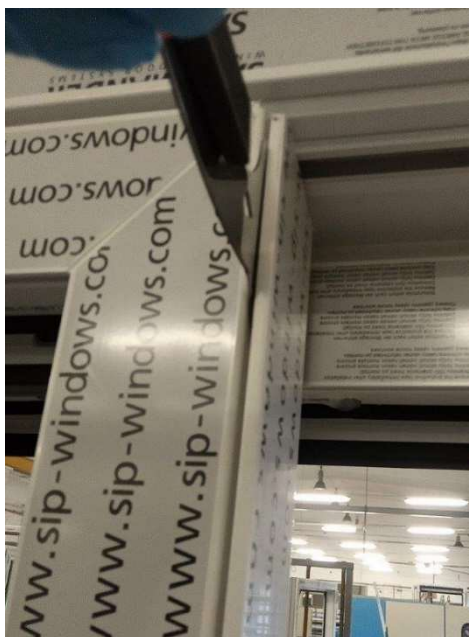
Fig... Démontage du cache du vantail. Fig... Dévissage de la vis fixant le support.
