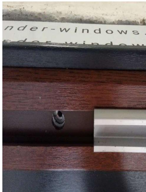
Fig... Démontage du support Fig... Trou pour la cheville sous le rail supérieur.
