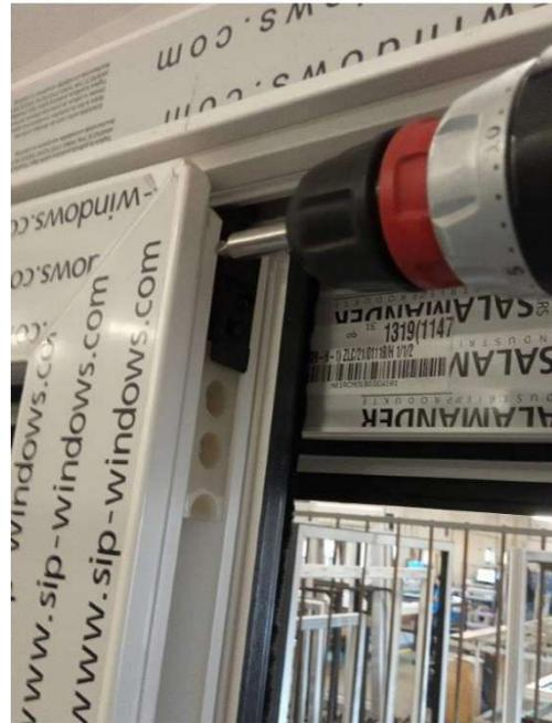
Fig... Démontage du cache du vantail. Fig... Dévissage de la vis fixant le support.
