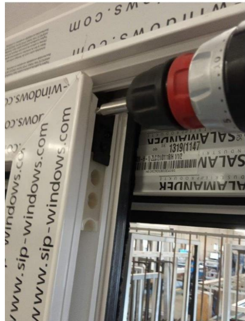
Rys.... Demontaż maskownicy skrzydła. Rys... Odkręcenie śruby mocującej wieszak.
