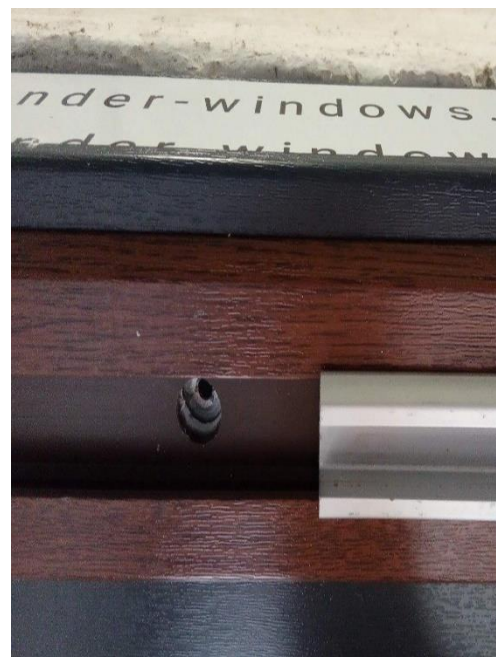
Rys... Otwór na dybel pod górną szyną.
