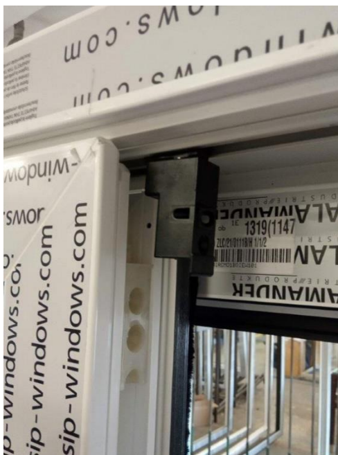
Rys.... Demontaż wieszaka.
