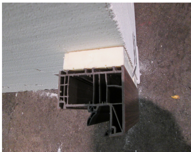
Ilustracja 4 : ilustracje 2 - 4 kotwienie przy zlicowanej óscieźnicy z zewnętrzną krawędzią muru.
