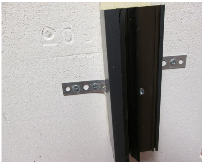
Ilustracja 5 i 6 kotwienie we wnęce okiennej bez węgarka
