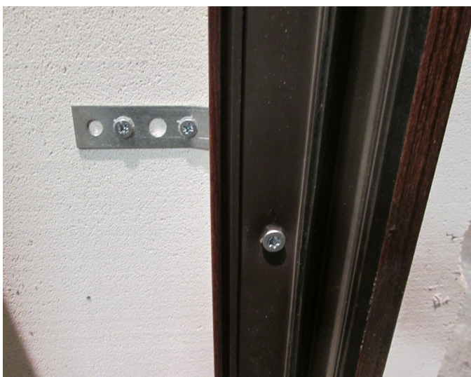
Ilustracja 7 i 8 kotwienie we wnęce z węgarkiem
