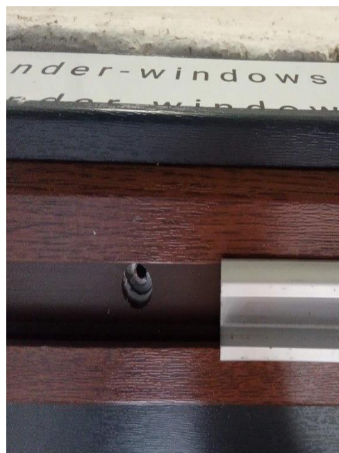
Obr... Otvor pre hmoždinku pod hornou koľajničkou.
