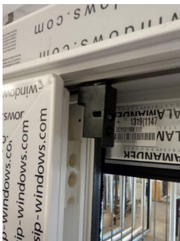
Obr.... Demontáž závesu koľajničky.
